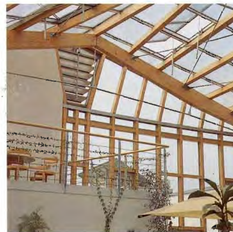
Blick auf die Holzkonstruktion mit Lüftungsgitter
